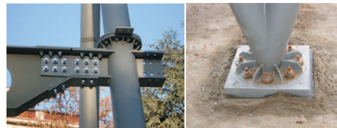
IN ALTO Le colonne inclinate e le travi alveolari durante la fase di montaggio della carpenteria metallica.
