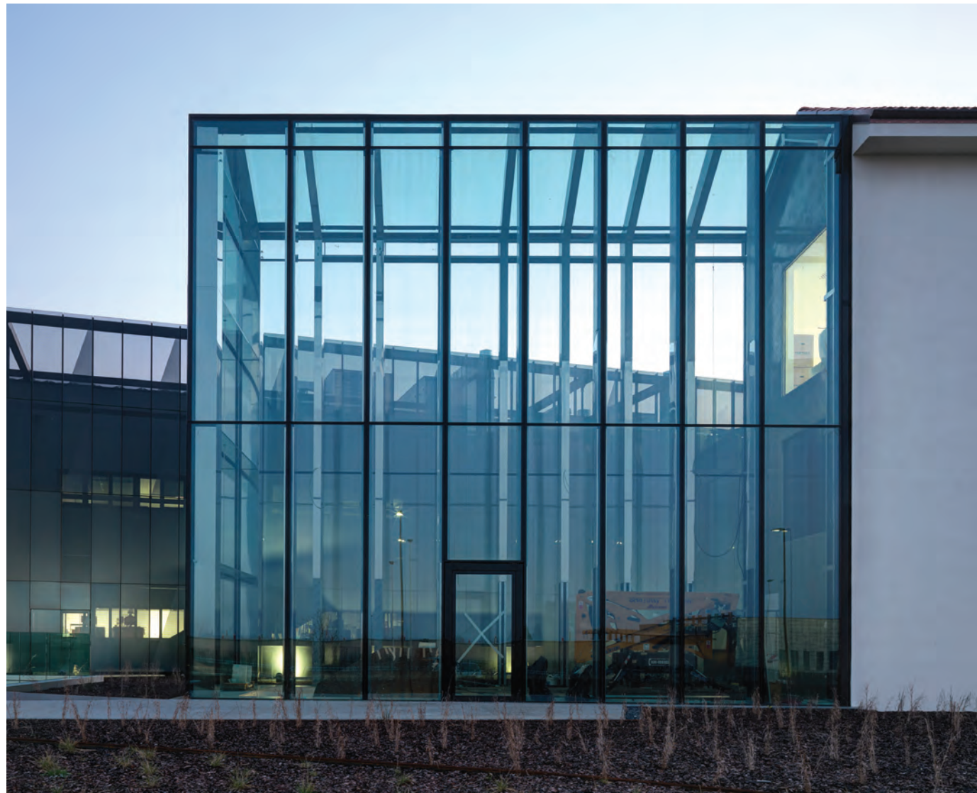
Vista della Glasshouse in acciaio e vetro.
