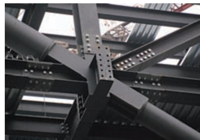
DETTAGLI DEI NODI DI GIUNZIONE
