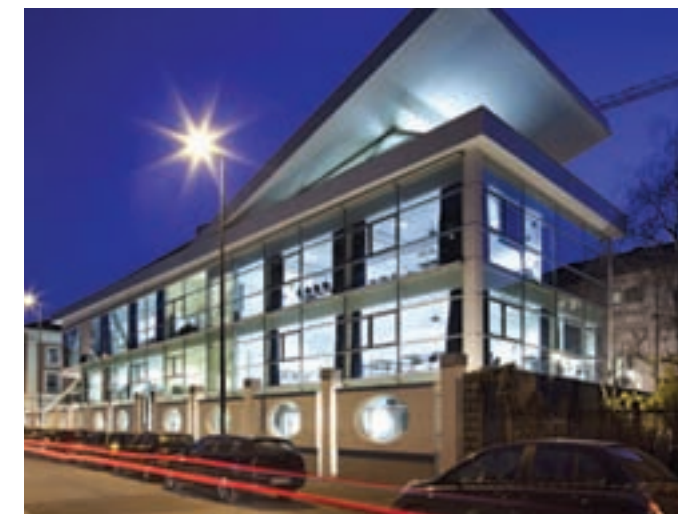
Vista dell'edificio A durante le fasi di cantiere e a lavori ultimati.
