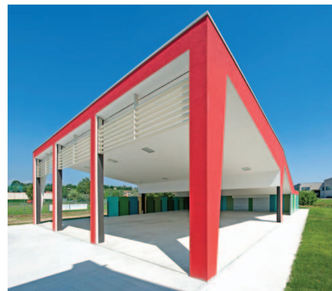
Vista del padiglione a cantiere ultimato.
