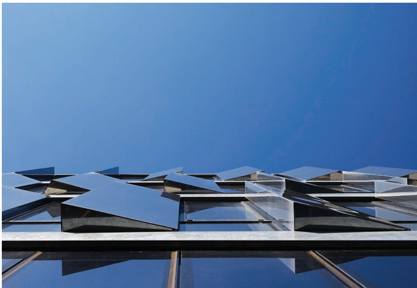
Dettaglio dei pannelli specchianti in acciaio inossidabile che scandiscono la facciata.
