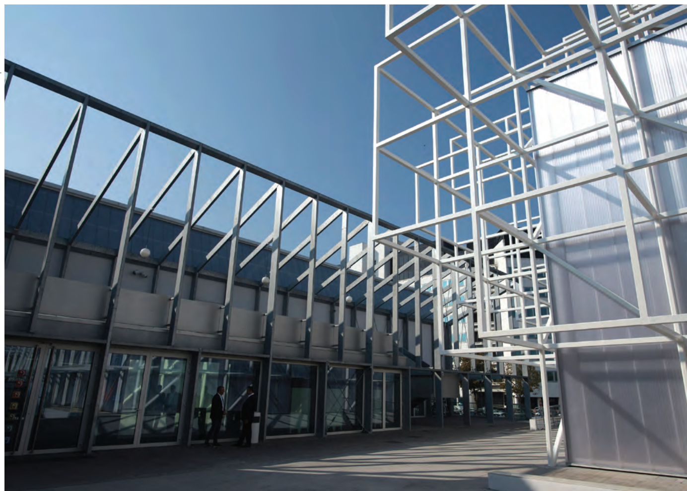
Il nuovo volume a confronto con l'edificio esistente anch'esso in acciaio e nato da un progetto di riqualificazione.
